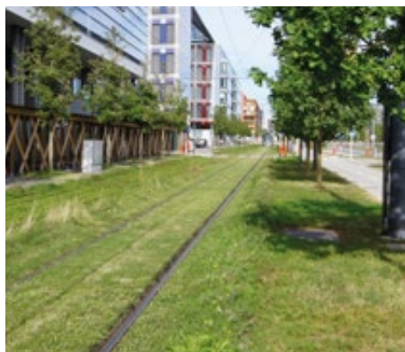
Anlage von Gleisbegrünung mit Gras
